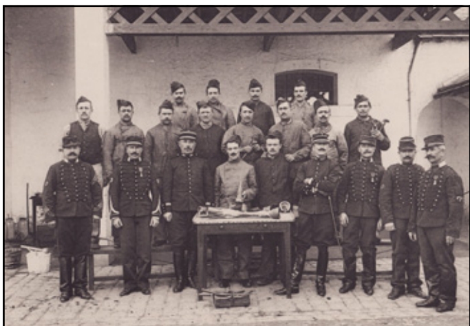
L'infirmerie vétérinaire Collection Ph CRENNER - Amicale du 3e Dragons et de l'EED3
