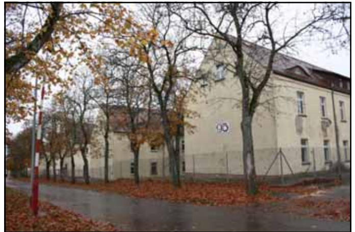
Dernière vue sur les bâtiments 95 à 99... Photo A JACQUET
