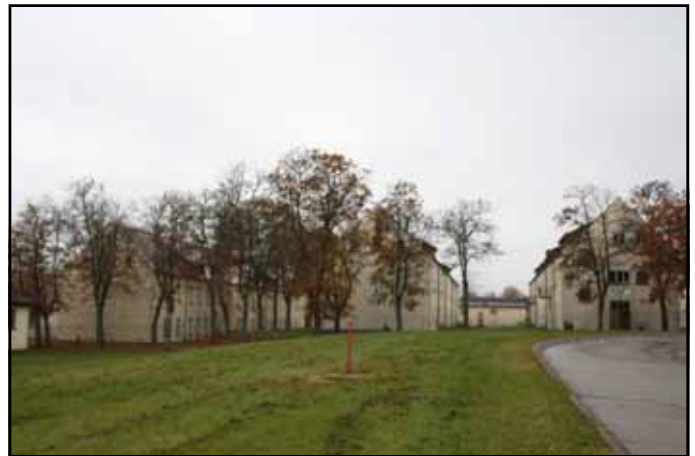
Vue sur des bâtiments vétustes Photo A JACQUET
