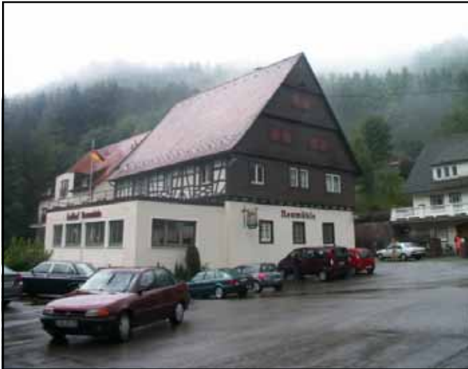
Le Neuemühle à Thiergarten Photo B COLAS
