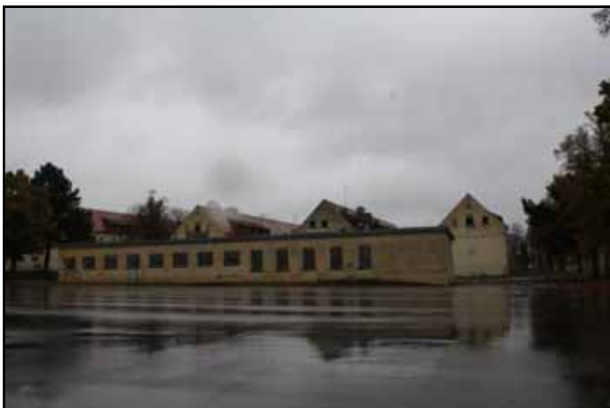
Ancienne place du rassemblement de l'ECS et bâtiment des Transmissions Au fond les bâtiments 95 à 99 Photo A JACQUET
